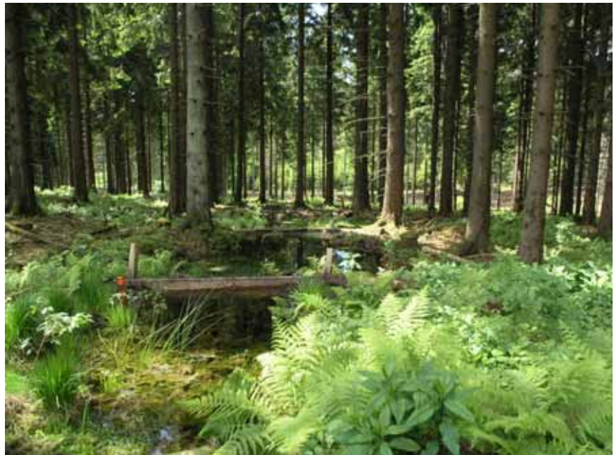
Querverbau an einem Drainagegraben in einem Fichtenbestand im Testgebiet Holzbach des EU-WARELA-Projekts. Diese Maßnahme dient dem Wasserrückhalt und trägt zur Verminderung der Entstehung von Hochwasser bei.
