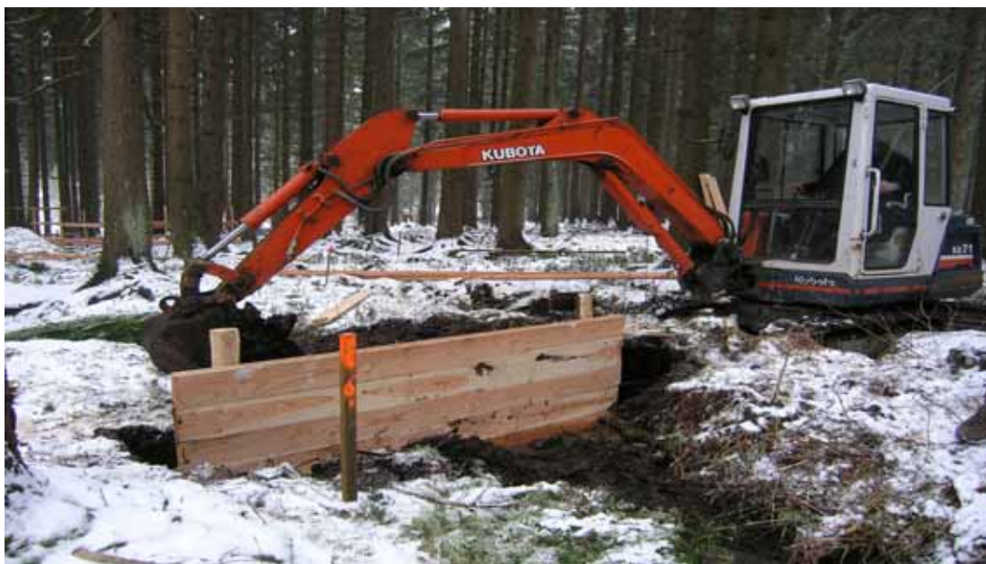
Abb. A8: Kleinbagger beim Anlegen eines Quergrabens für den Bretterdamm im Testgebiet Holzbach
