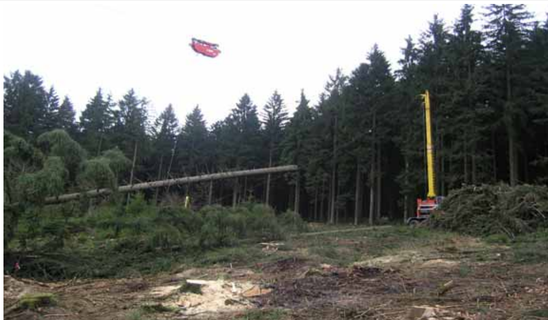
Abb. A10: Bodenschonung durch Bringung der Baumstämme mittels eines Seilkranes im Testgebiet Holzbach Fig. A10: Soil protection by extraction the logs by a cable crane in the test site „Holzbach“
