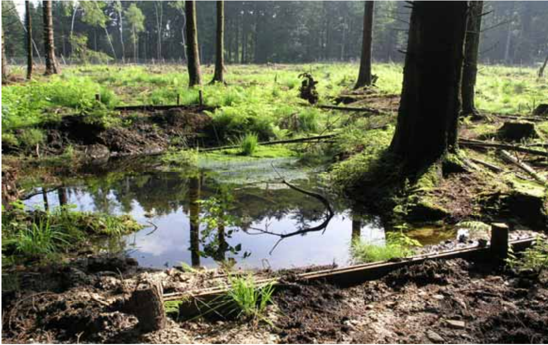
Abb. A9: Grabenverschluss durch Bretterdamm im Testgebiet Holzbach in der ersten Vegetationsperiode Abb. A9: Sealted "wooden plank dam" in the test site „Holzbach“ after the first vegetation period
