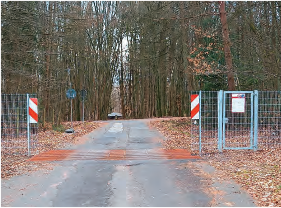
Abb. 6: Zaunanlage mit Wildrost zur Verhinderung von Wildquerungen bei weiterhin gegebener barrierefreier Versorgungszufahrt. Fußgänger können die Anlage ungehindert passieren. Jedoch gilt es gerade das zu verhindern, will man effektiv eine Biosicherheit um die Anlagen gewährleisten (A 1, Raststätte Eifel West, 26.3.2021, ©FAWF).
