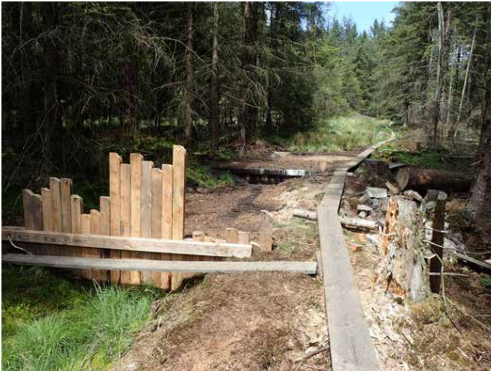
Abbildung 32: Grabenverschluss im Thierbruch (Foto: KOPF).
